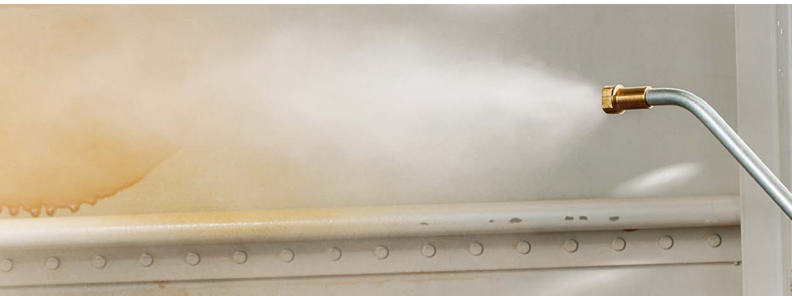
Распыление антикоррозионного покрытия Ardrox® AV (CIC)
